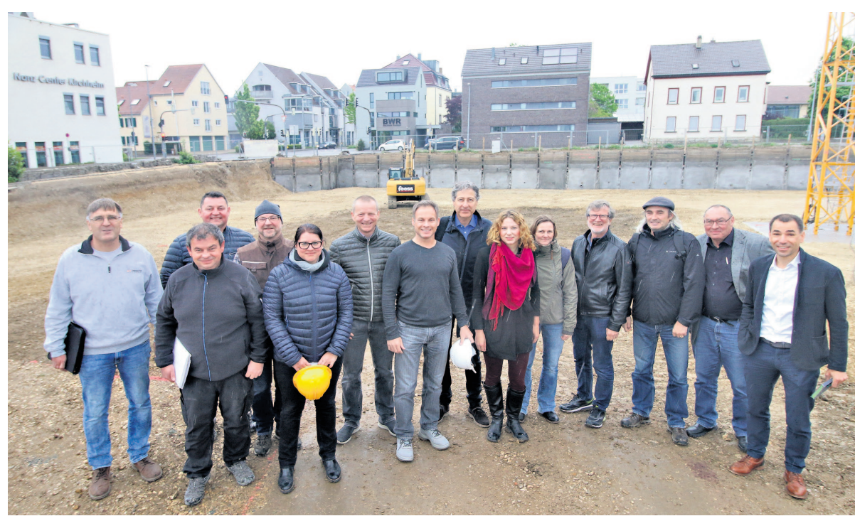
Architekten und Baubeteiligte am Start: Baubeginn auf bisher größtem Baufeld im Steingauquartier
