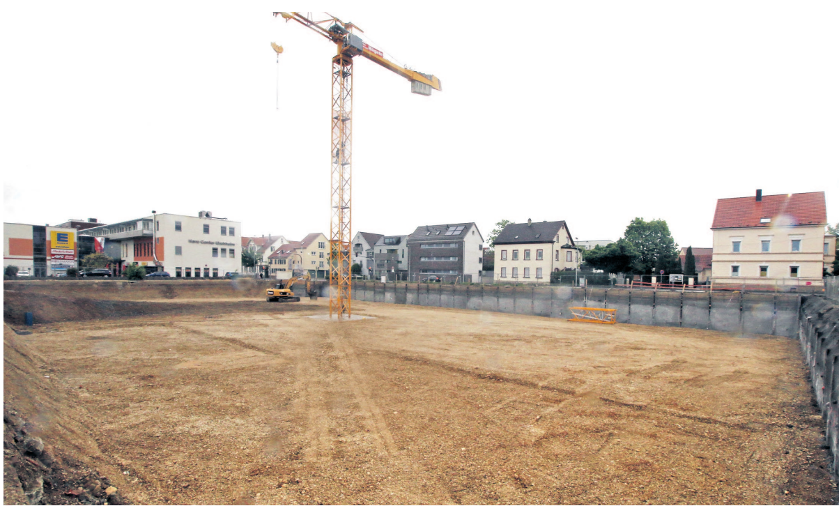
Baugrubenverbau und Erdarbeiten in Baufeld 2 für über 500.000 Euro
